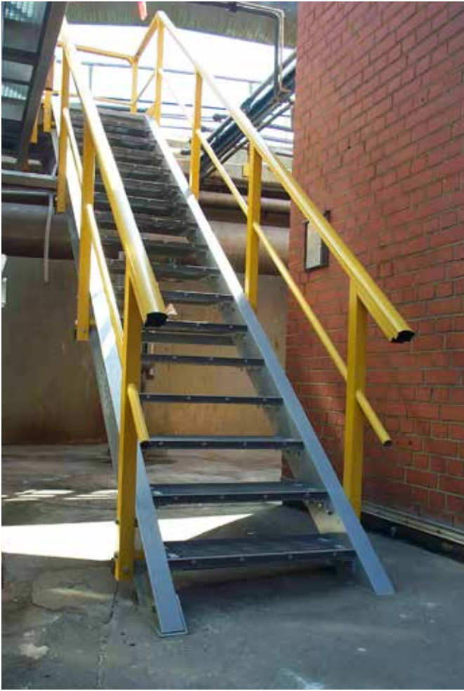
Oben links: GFK-Treppe freitragend
