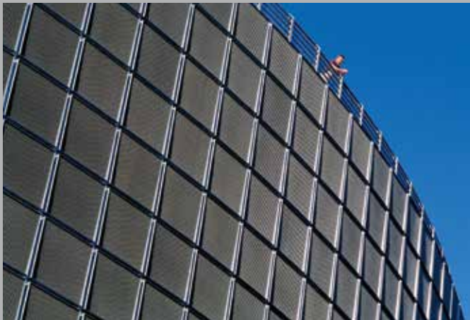
Parkhausverkleidung mit verzinkten Vollrosten
