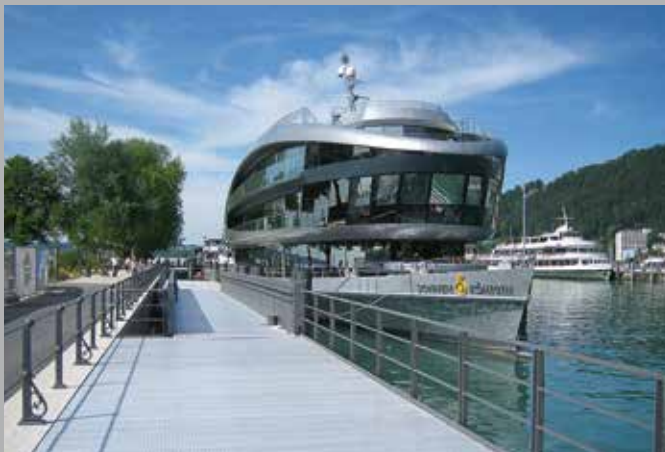
Bootslaufsteg aus Blechprofilrosten
