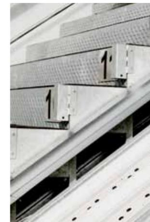
Modernste Schanzentechnik für die Große Olympiaschanze in Garmisch-Partenkirchen geplant und geliefert von Lichtgitter. Blechprofilroste unterschiedlicher Typen sorgen für sicheren Stand auf 314 Stufen und 17 Zwischenpodesten der Haupttreppe sowie auf den Medien- und Startstufen und der anlaufbegleitenden Treppe.
