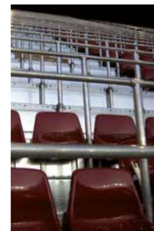
Bohrungen in den Belägen und Profilen dienen der Befestigung von Sitzen und Geländern. Dies beschleunigt die Montage erheblich. Den Zuschauern dienen die strapazierfähigen und rutschfesten Bleche als idealer Resonanzkörper.
