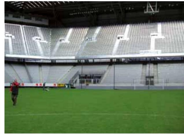
Bei einer derart imposanten Naturkulisse im Hintergrund durfte auch die Optik der Stadionerweiterung in Innsbruck nicht nachstehen. Der Übergang zwischen den vorhandenen, unteren Rängen aus Beton und den durch Lichtgitter gelieferten, oberen Rängen aus Stahl ist aus der Distanz kaum auszumachen.
