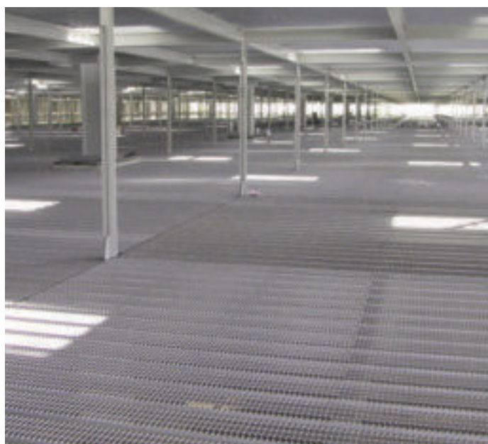
Zwischendecke BMW Regensburg
