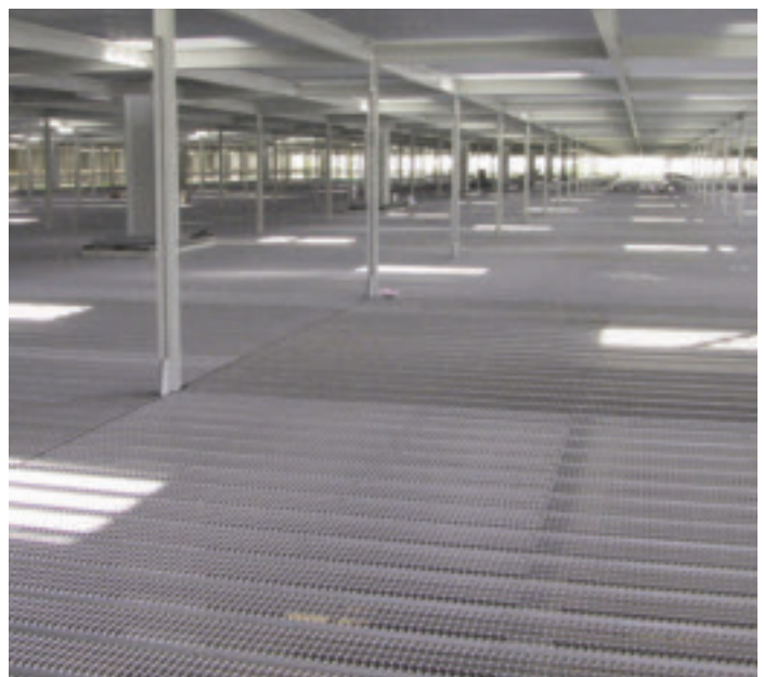
Zwischendecke BMW Regensburg
